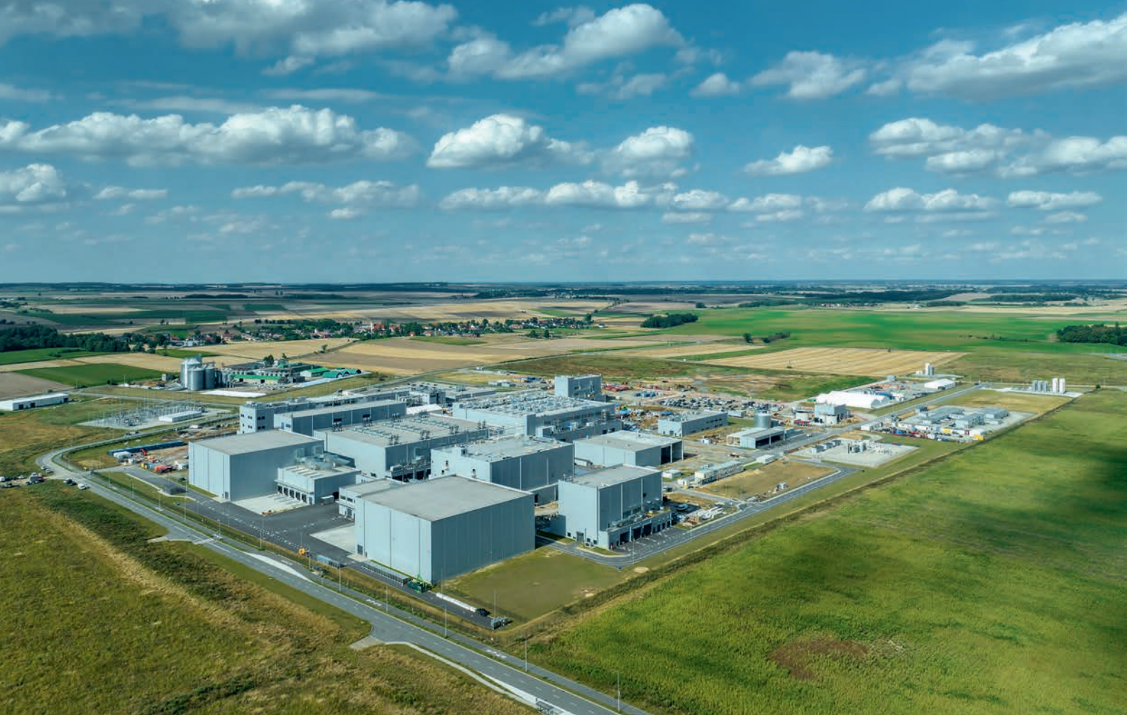
Umicore betreibt Europas erste kohlenstoffneutrale Gigafactory für Batteriematerialien in Nysa, Polen
